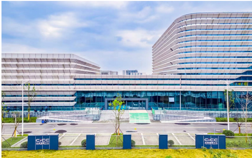
作为“东数西算”国家一体化大数据中心成渝枢纽节点的样板工程,成都智算中心落地郫都区,助力郫都经济高质量发展。 孙浩 摄
