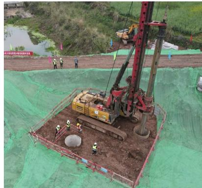
麻子滩水库大桥施工点,旋挖钻正在进行桩基作业。
