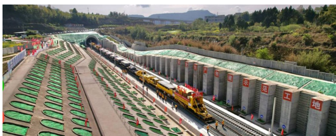
汉巴南铁路南充至巴中段开始铺轨。
