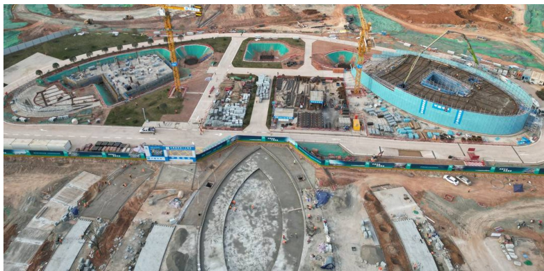
综合服务馆B馆(图右建筑)主体结构顺利封顶。
