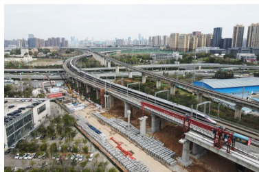
施工点邻近既有线路。
