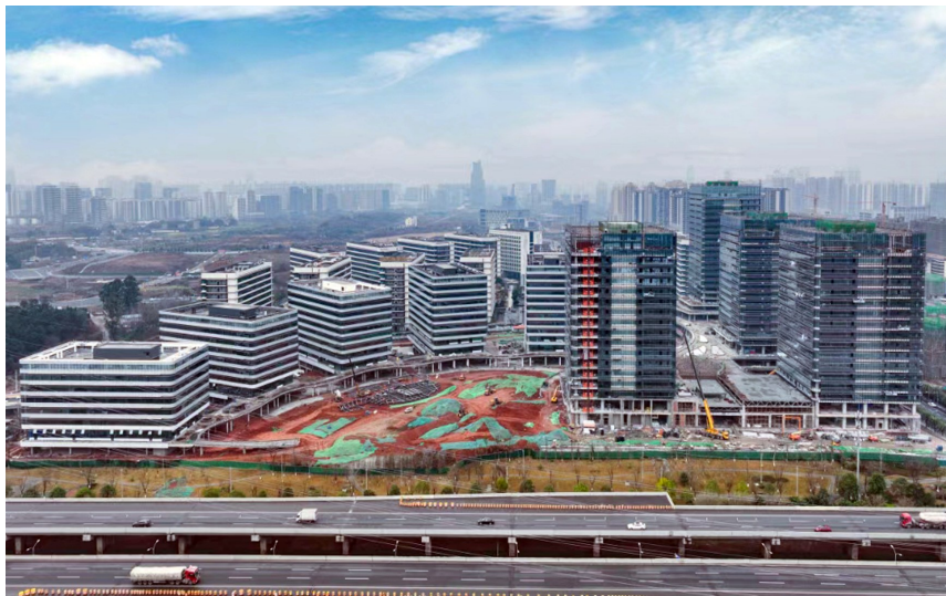
天府锦城实验室二期载体封顶。
