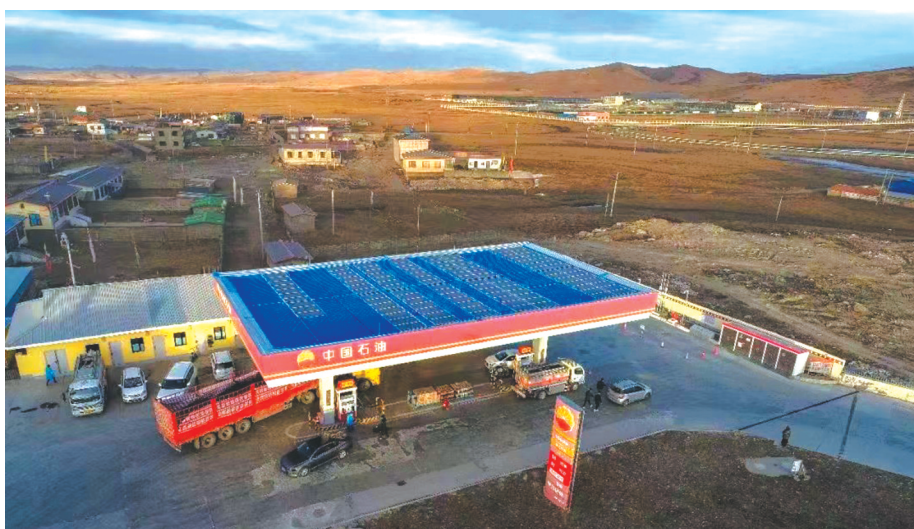
中国石油四川销售公司已累计在位于川西北高原的14座加油站安装投运光伏发电设备。
