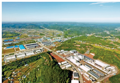
射洪锂电高新产业园。
