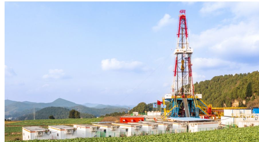
位于绵阳市盐亭县境内的蓬深6井。中国石油西南油气田公司供图
