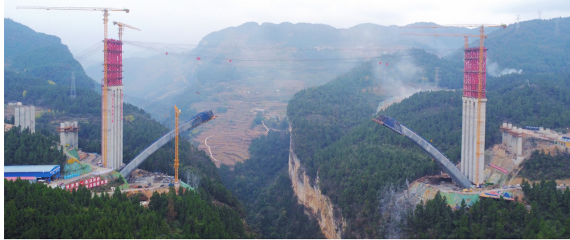
航拍古金高速水落河特大桥。龙欣雨 摄
