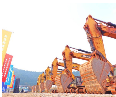
南充临江新区西充片区第一季度重大项目集中开工。
