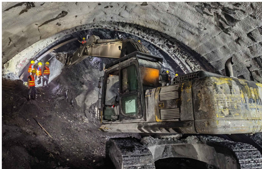
成兰铁路德胜隧道施工人员正在安装支护。
