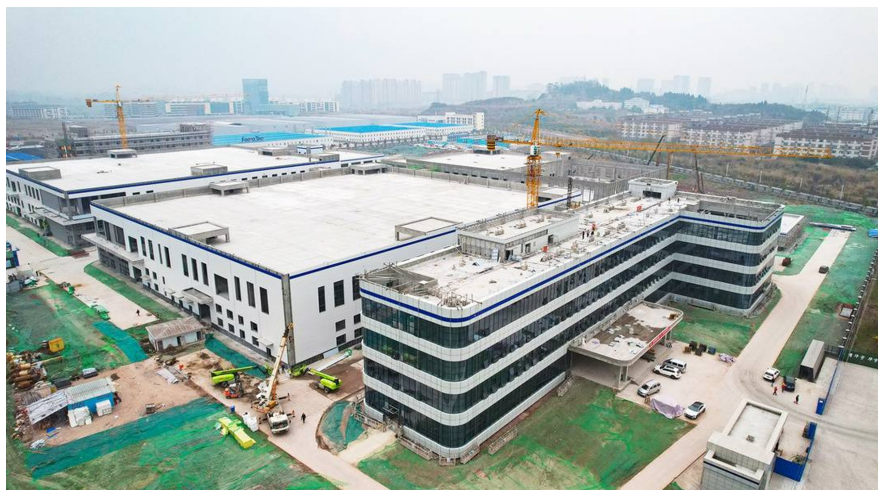
建设中的四川富乐华功率半导体陶瓷基板项目。
