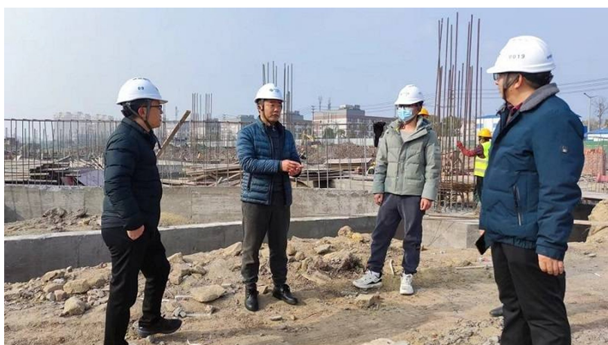
项目中心对在建设项目进行现场督导。
