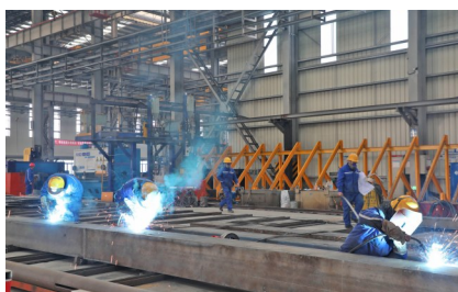
钢结构生产基地一派繁忙景象。
