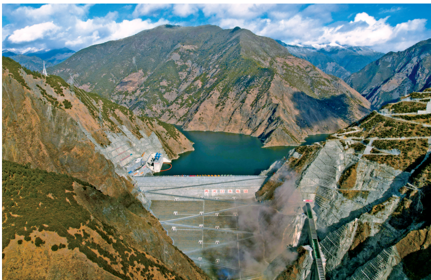
2022年12月29日拍摄的雅砻江两河口水电站水库（无人机照片）。新华社发
