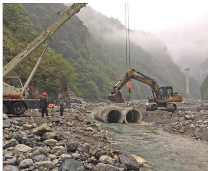
施工人员重修被山洪摧毁的便道(2018年9月摄)。受访者供图
