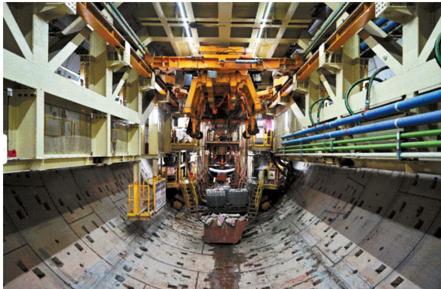
成自宜高铁施工现场。
