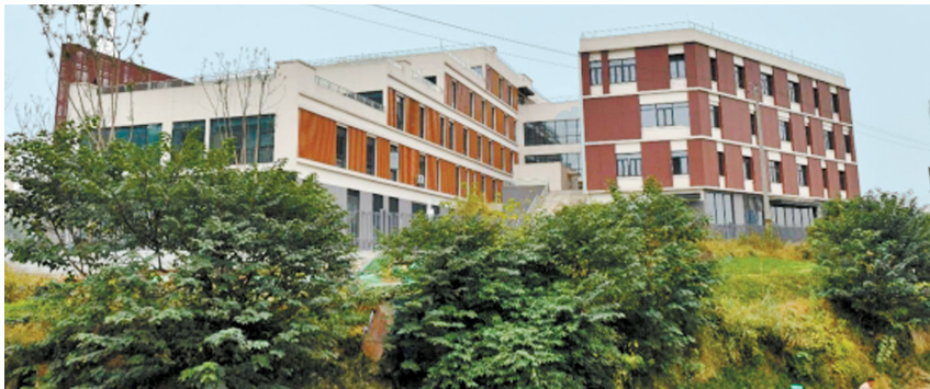
位于成都高新区的一个便民综合体项目建设内容已完工。
