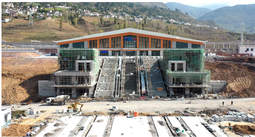
成昆复线甘洛南站站前广场施工现场。甘洛县融媒体中心供图
