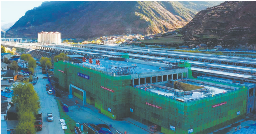
松潘站工程钢结构全部封顶。
