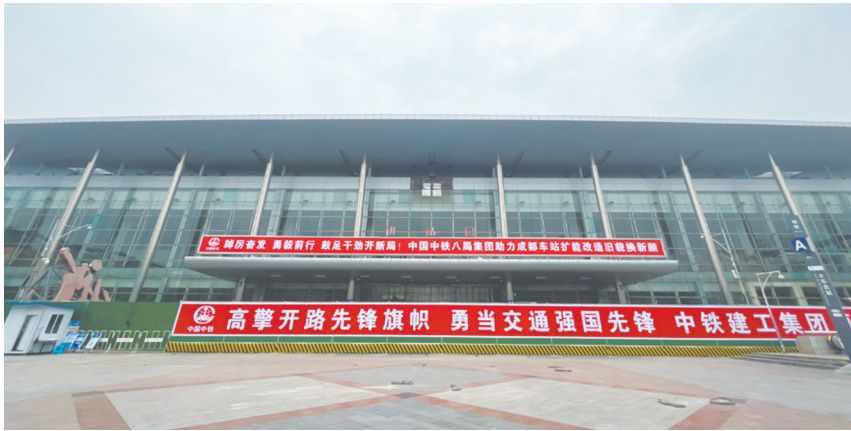
成都站老站房已拆除“成都”二字及站房正面的挂钟。
