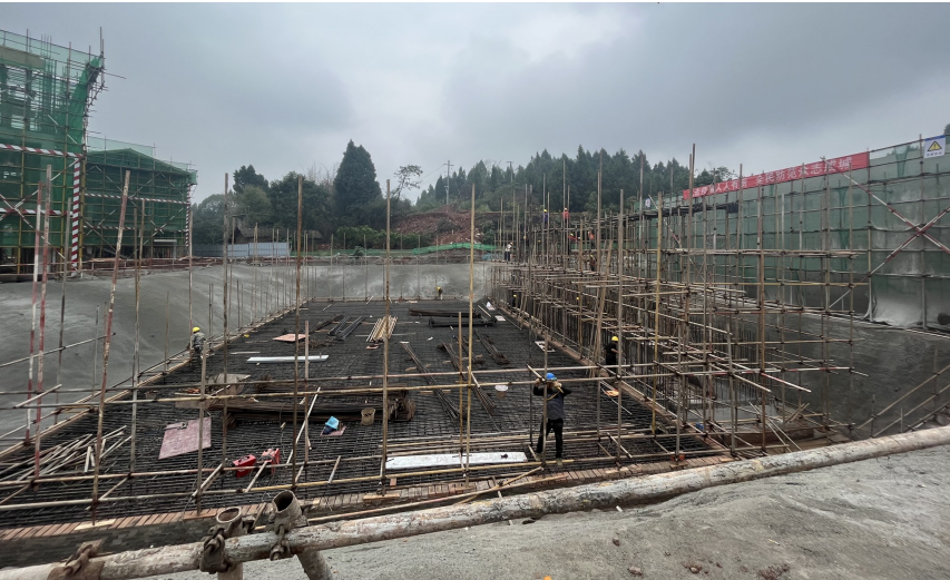
资阳市城东自来水厂建设现场。
