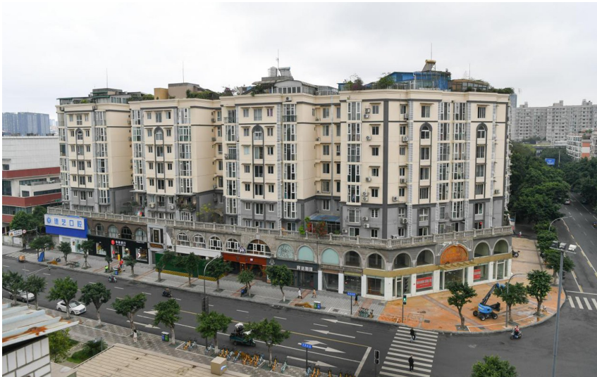
改造后的新玉林城市公寓。成都高新区公园城市建设局供图
