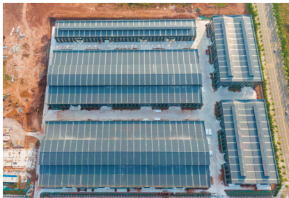
四川星耀新能源科技有限公司厂房建设已基本完成。
