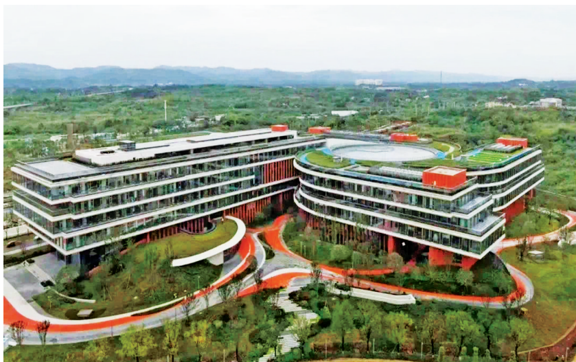
西部设计产业园竣工,标志着成都东部新区又一全新产业载体即将投用。
