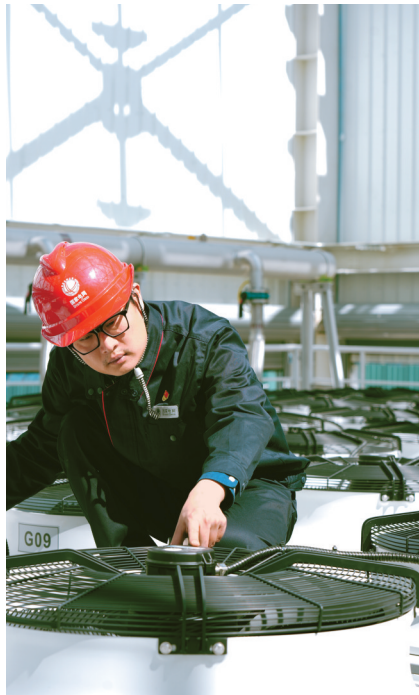
张鸣镝在布拖换流站建设现场检查设备安装情况。 刘湘机 摄
