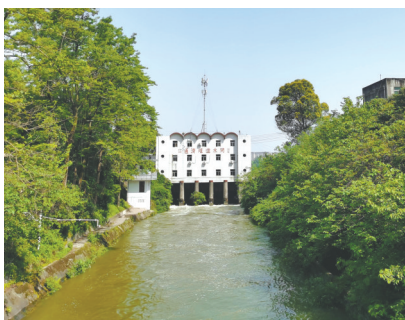
通济堰进水闸。
