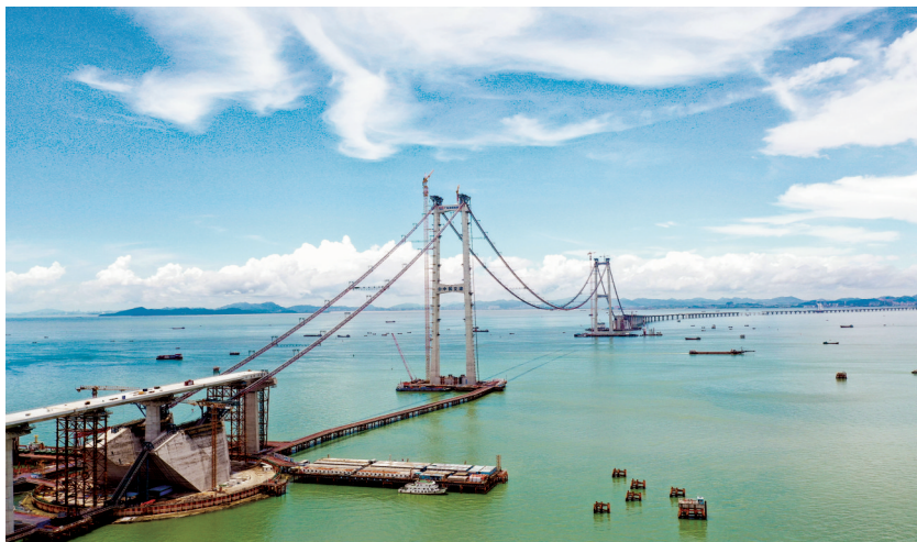
深中通道关键控制性工程伶仃洋大桥的建设现场。新华社发
