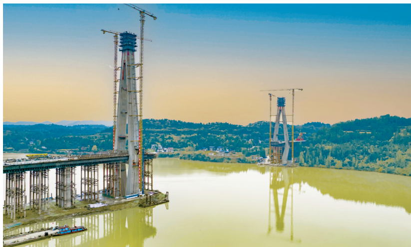
汉巴南铁路嘉陵江特大桥两个主塔全部封顶。
