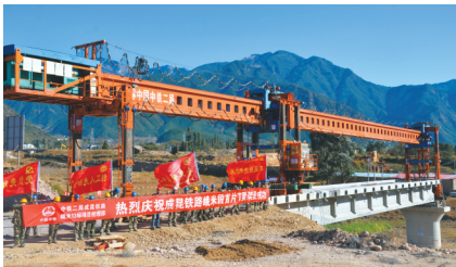
中国银行四川省分行为中铁二局集团提供金融服务支持,助力成渝地区双城经济圈建设。
