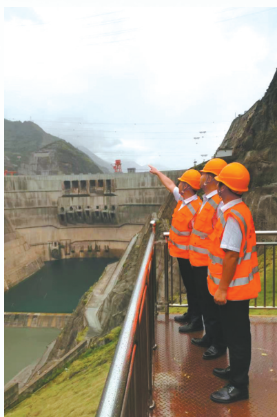
助力“西电东送”国家重大工程建设, 中国联通为白鹤滩水电站建设精品5G网络集成系统, 实现全站5G网络全覆盖。
