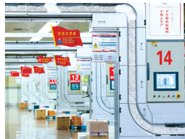
四川中烟生产车间里的党员示范岗。
