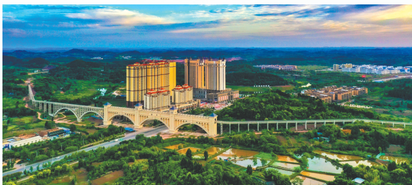
位于乐至县境内的毗河供水一期工程卢家坝渡槽。姚阳 摄
