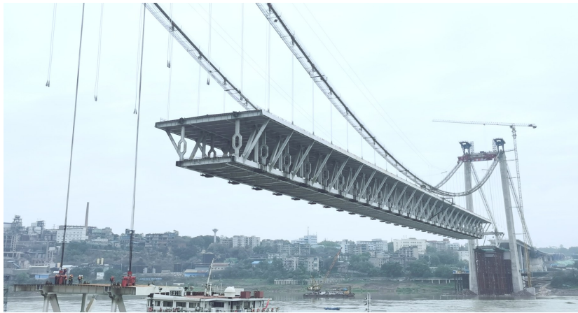
建设中的泸州长江二桥。
