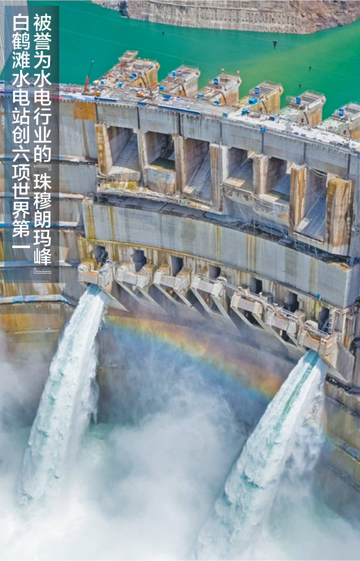
2021年6月10日拍摄的白鹤滩水电站(无人机照片)。 新华社发
