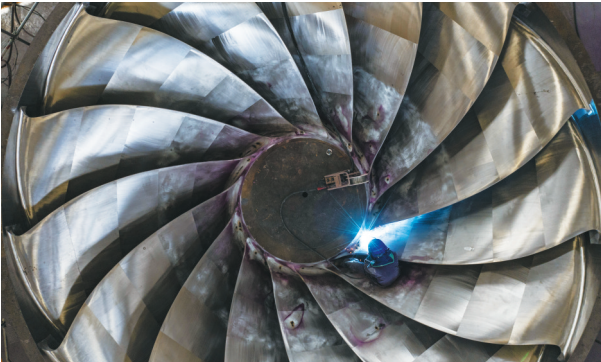
工人对白鹤滩水电站发电机组所需的转轮进行局部消缺处理。
