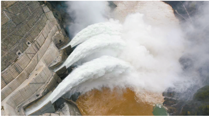
白鹤滩水电站泄洪洞正在泄洪。王孝海供图
