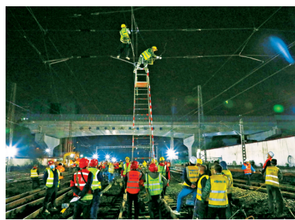
接触网作业人员进行成都站软横跨调整。 中铁电气化局供图
