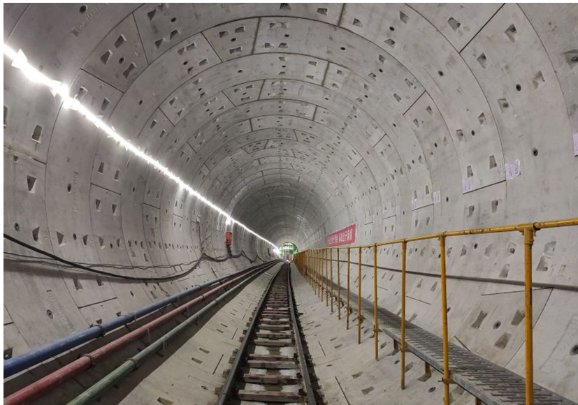
贯通后的红牌楼站-高升桥站盾构区间。
