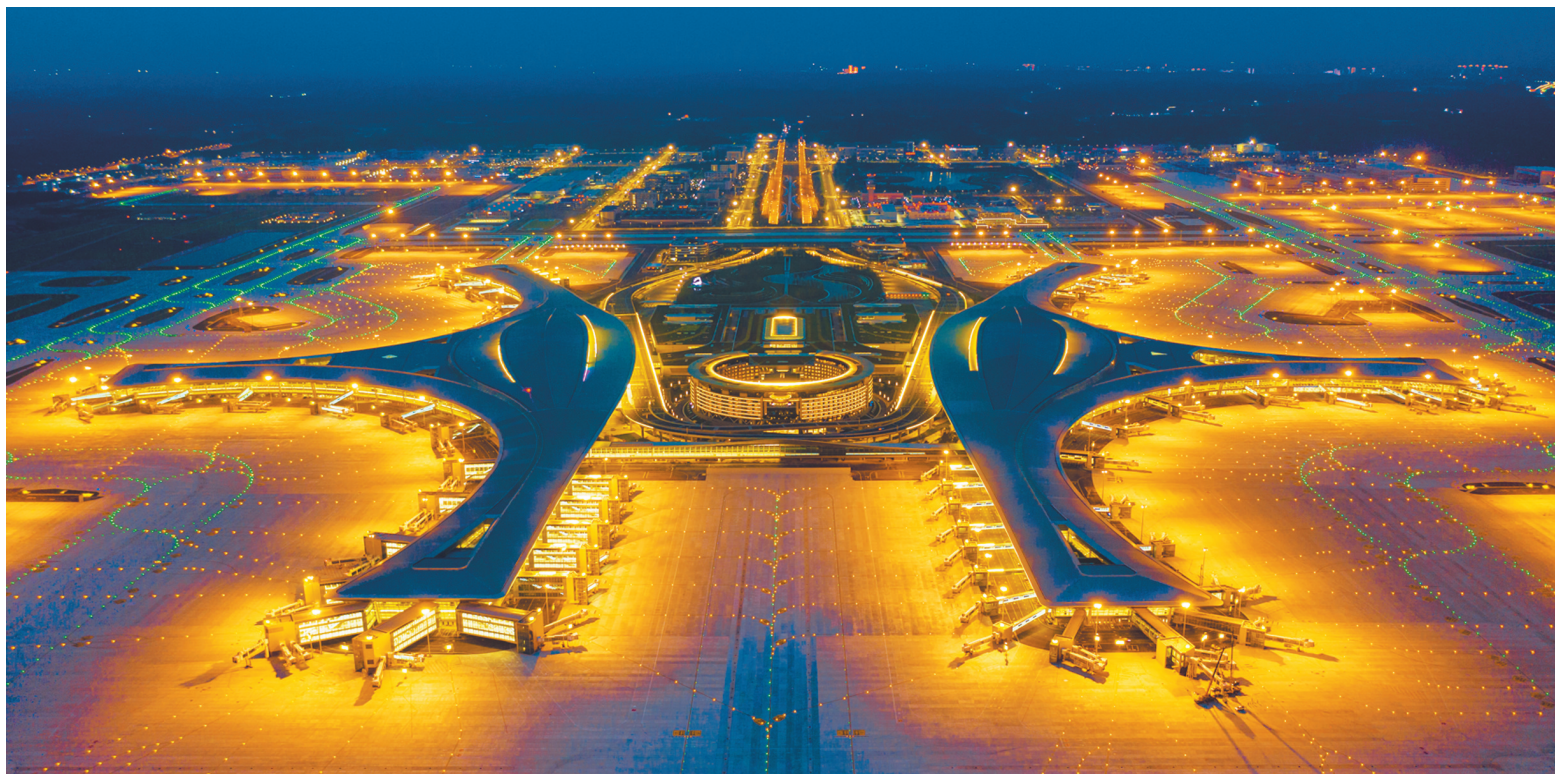
成都天府国际机场夜景。成都天府国际机场供图
