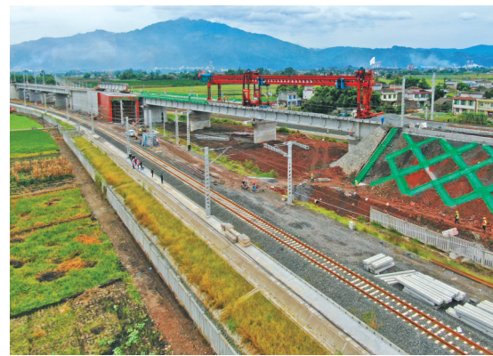
▲9月20日,新成昆铁路燕岗双线大桥T梁架设完成。成昆铁路有限责任公司供图
