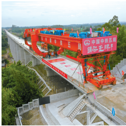
成自宜高铁全线首个标段完成箱梁架设。
