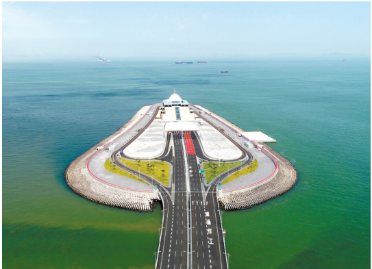
2018年7月11日无人机拍摄的港珠澳大桥东人工岛。
