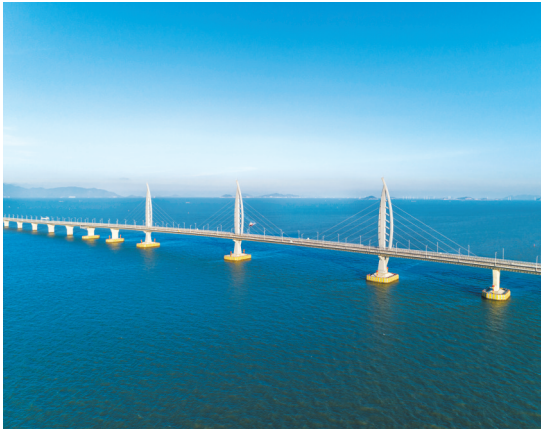
港珠澳大桥江海航道桥。港珠澳大桥管理局供图
