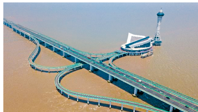
鸟瞰杭州湾跨海大桥(2018年4月19日无人机航拍)。新华社发
