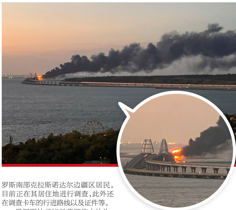
▲10月8日拍摄的克里米亚大桥起火现场。 新华社发
