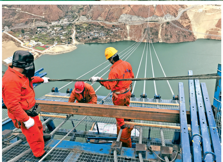
工人们架设桥梁缆索。
