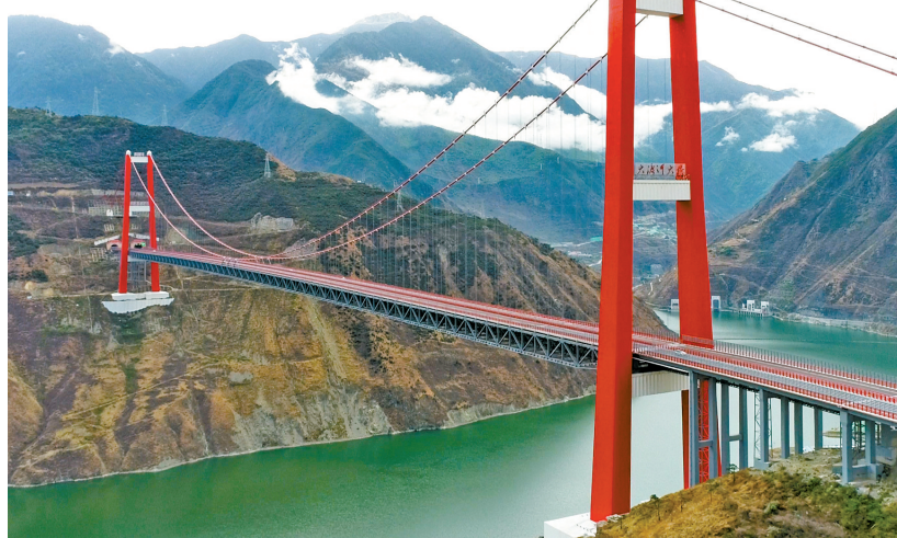
雅康高速公路泸定大渡河大桥。
