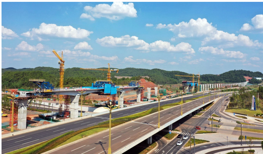
资阳线上跨纵二路悬灌连续梁顺利合龙。
