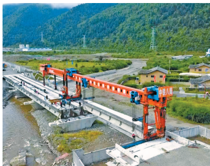
成兰铁路成川段高原区段T型梁架设现场。成兰铁路有限责任公司供图
