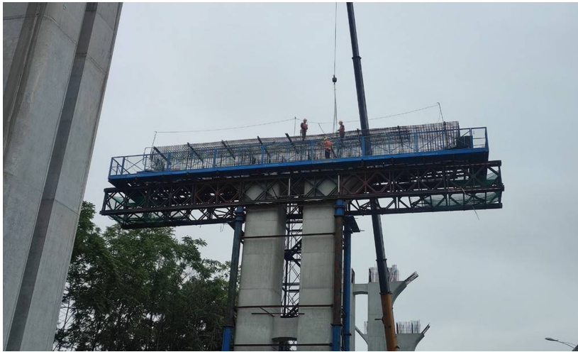
成绵扩容项目成都段盖梁施工。
