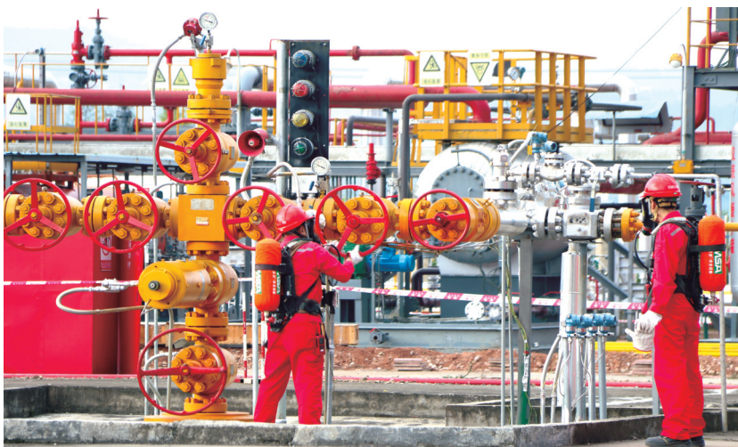
中石化西南石油局集输气站员工维护气井。
