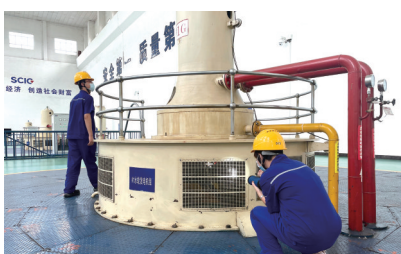
川投集团所属水电站员工检修发电机组设备。
