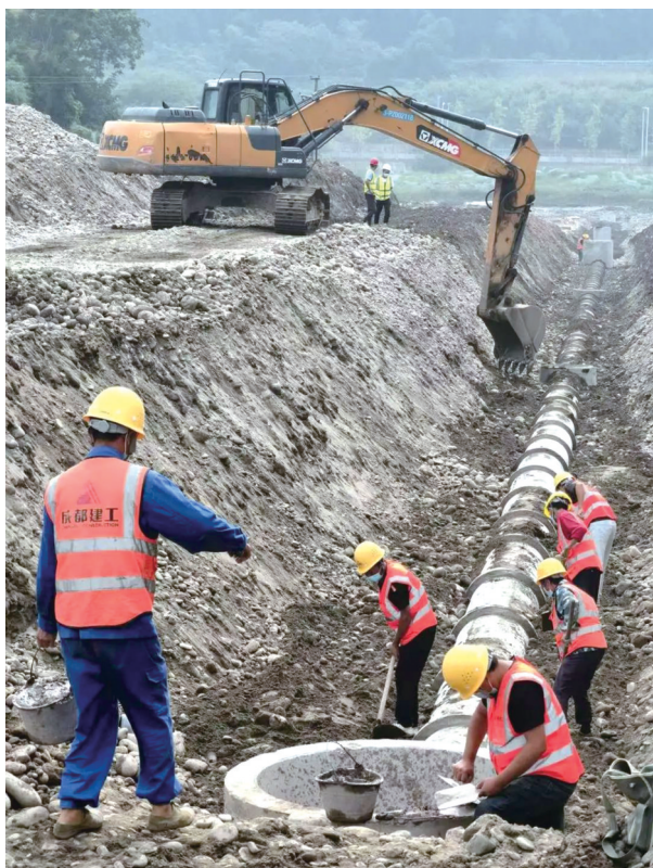
新津区兴普大道施工现场。
