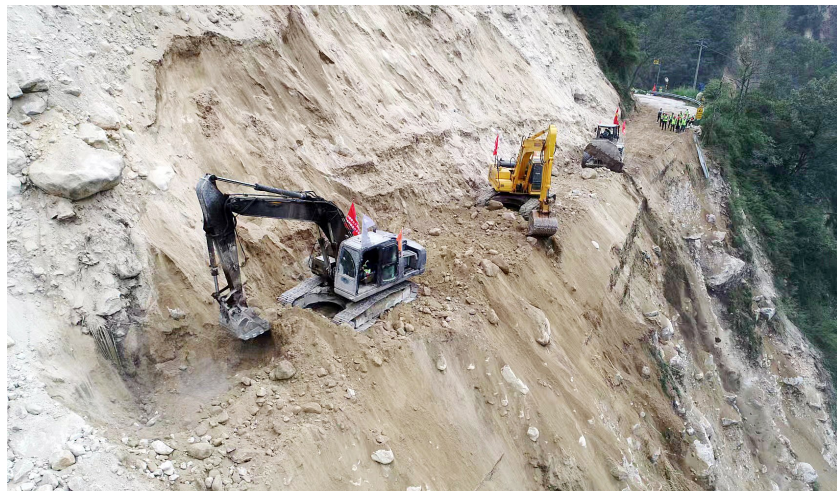
陡峭的悬崖上,抢险队正在作业。
