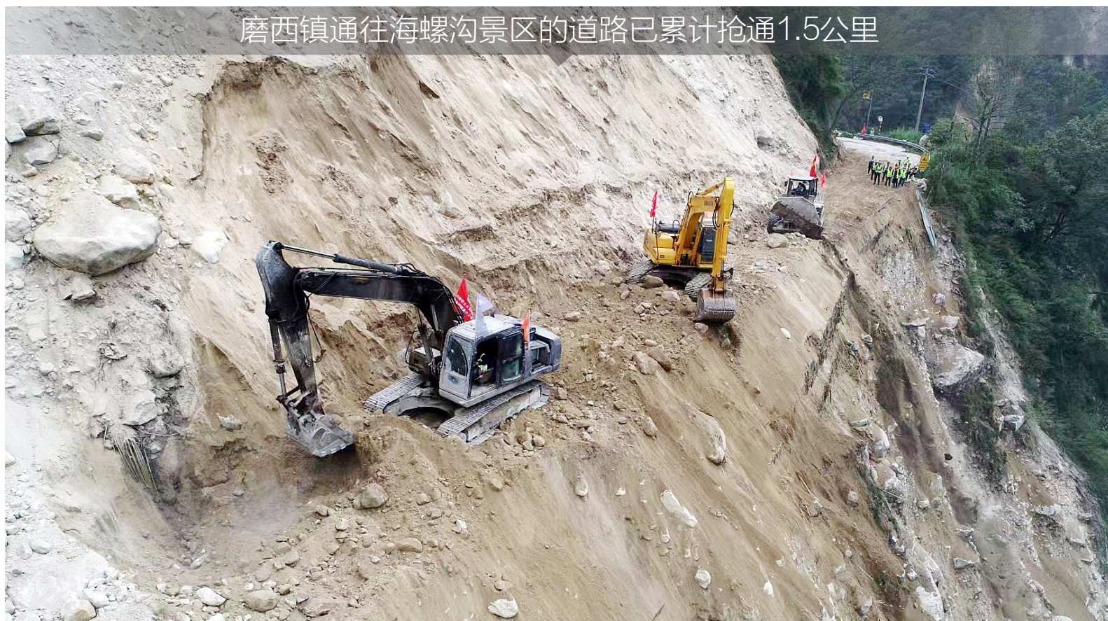
陡峭的悬崖上,抢险队正在作业。
