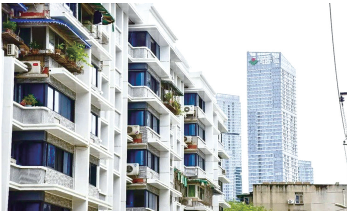
成都锦江区青龙正街风貌提升项目。锦江融媒体中心供图
