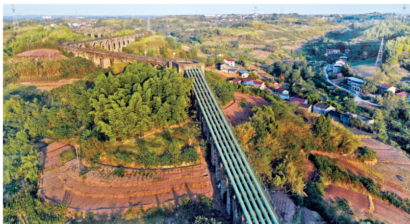
架设在空中的沱灌工程管道和渡槽。王斌摄
