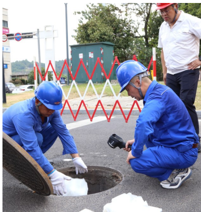
工人正在向电缆井投放冰砖。
